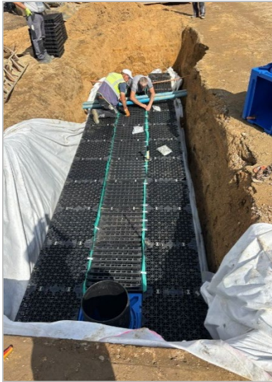
Einbau der Versickerungsanlage E (8,4 m x 1,8 m x 0,6 m)
