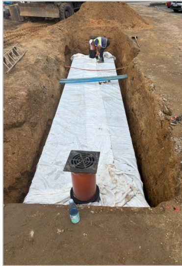
Einbau der Versickerungsanlage E (8,4 m x 1,8 m x 0,6 m)
