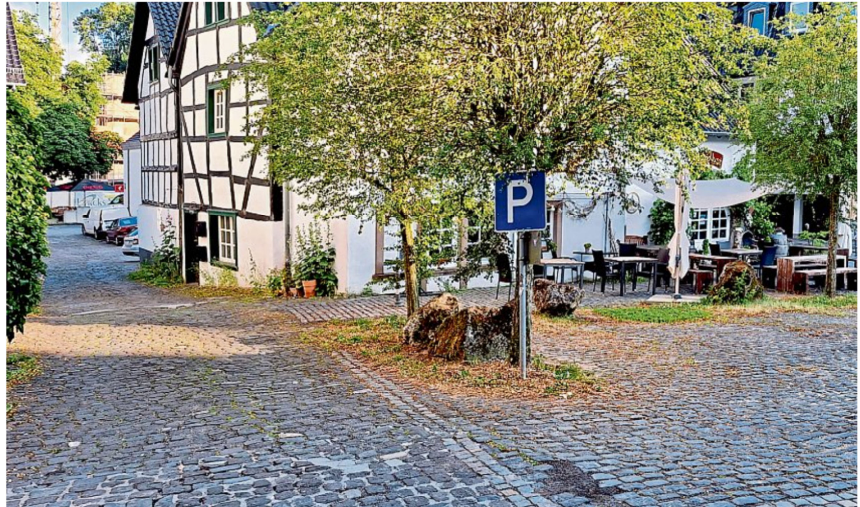
Klosterstraße und Parkplatz am Curtius-Schulten-Platz: Die Pflanztröge kommen weg, die Stellflächen werden vergrößert. Das alte Kopfsteinpflaster wird komplett ausgehoben, die Steine entweder abgesägt und wiederverlegt oder durch neue ersetzt. Fotos: Stefan Lieser
