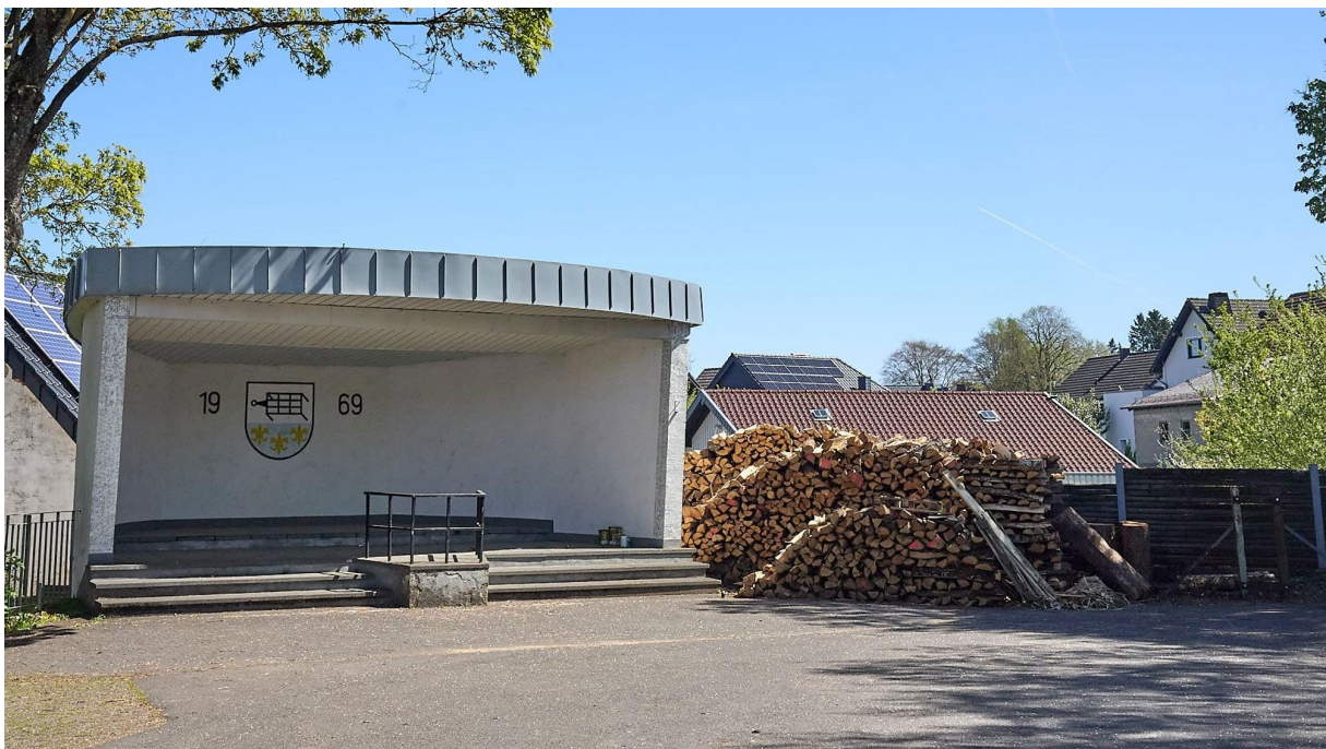
Ein Überbleibsel aus der ersten Sanierung des Platzes von 1969 ist die überdachte Bühne. Copyright: Stephan Everling
