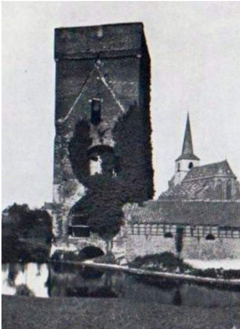
Dieses alte Foto zeigt den Gangelter Bergfried vor der Restaurierung. Foto: Archiv Lutz Vorbach
