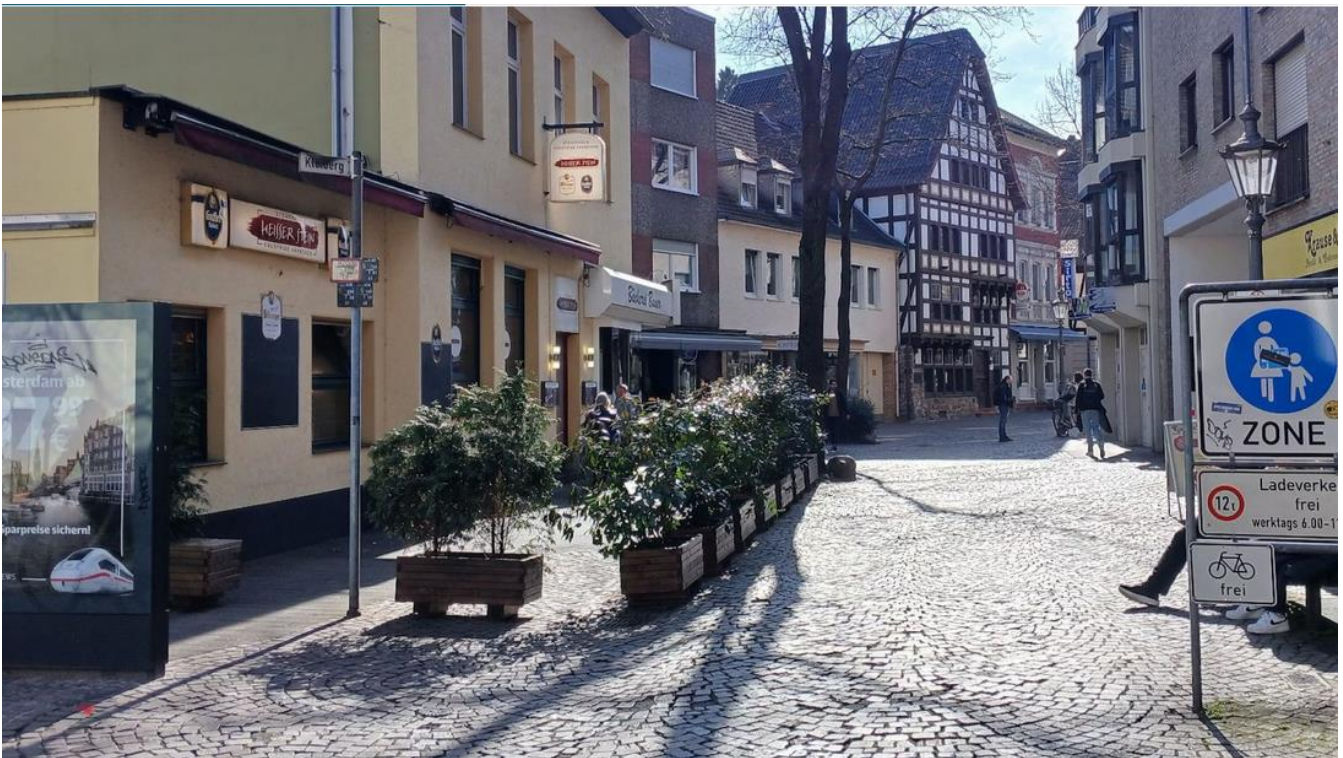
Die Holzgasse muss dringend saniert werden, vor allem das in die Jahre gekommene Pflaster.
