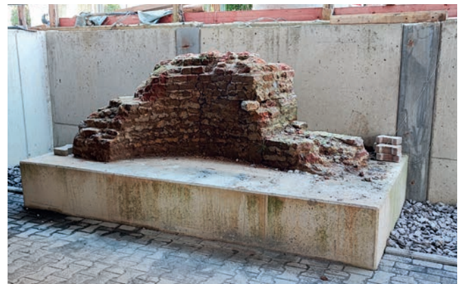
Während der Bauarbeiten wurden Reste der mittelalterlichen Stadtmauer gefunden, die in den Bau integriert wurden.
