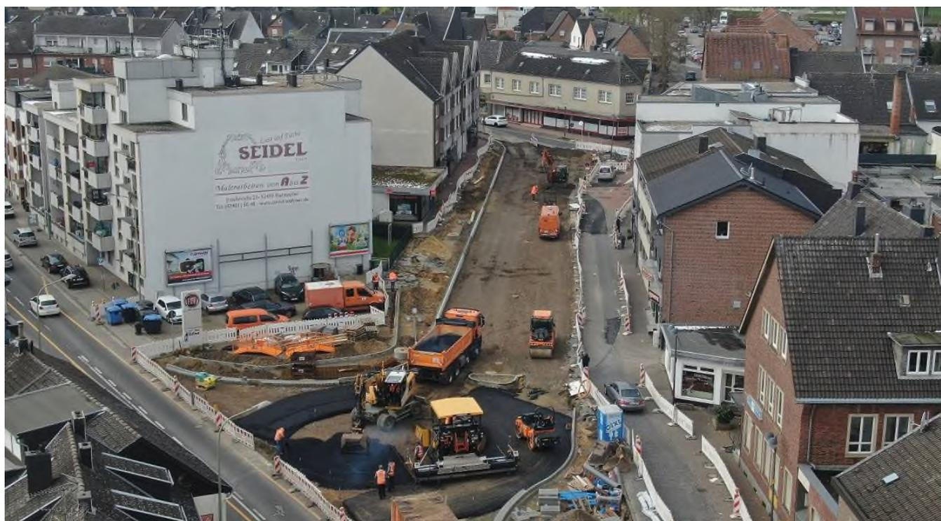
Aus der Vogelperspektive: Das Drohnenbild vom Bauplatz Zentraler Omnibusbahnhof (ZOB) entstand vor ein paar Tagen zu Beginn der Asphaltierungsarbeiten. Bereits gut zu erkennen ist der neue Kreisverkehr, der das Einfädeln der Busse in die Aachener Straße (links) erleichtern soll. Foto: IQ Ingenieurgesellschaft Quadriga mbH
