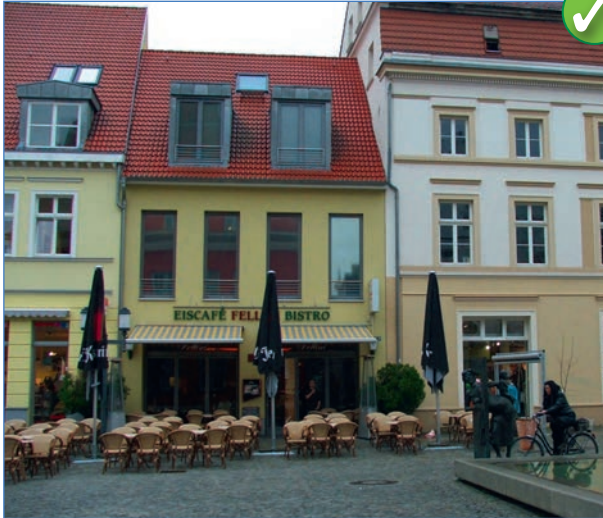
Abbildung 84: Markisen berücksichtigen die Fassadengliederung
