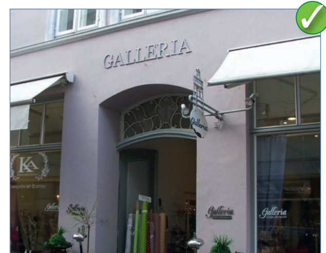
Abbildung 82: Markisen berücksichtigen die Fassadengliederung
