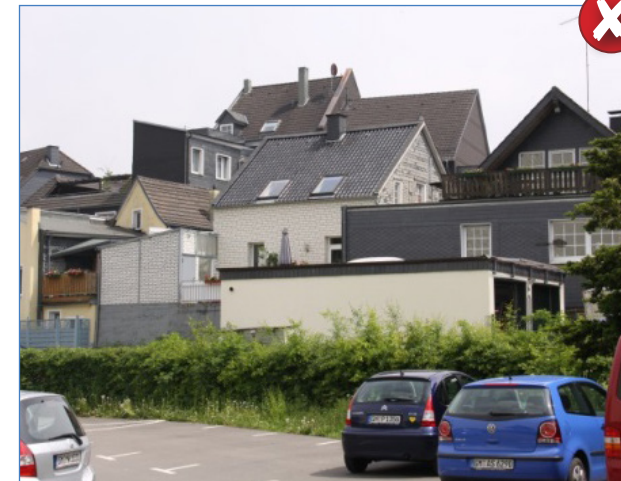
Abbildung 43: unterschiedliche Dachformen /-ausrichtungen bewirken unruhigen Gesamteindruck
