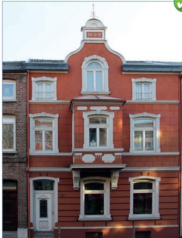
Abbildung 57: Erker am Gebäudealtbestand: Dammstraße
