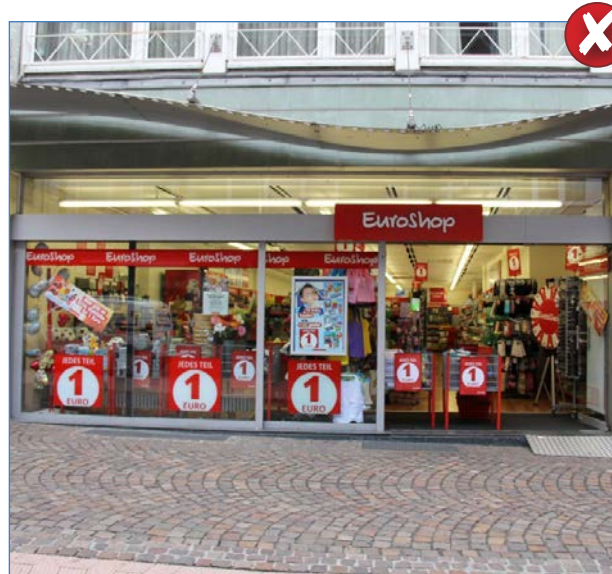
Abbildung 87: durch Werbung überfrachtete Schaufenster bewirken negatives Erscheinungsbild
