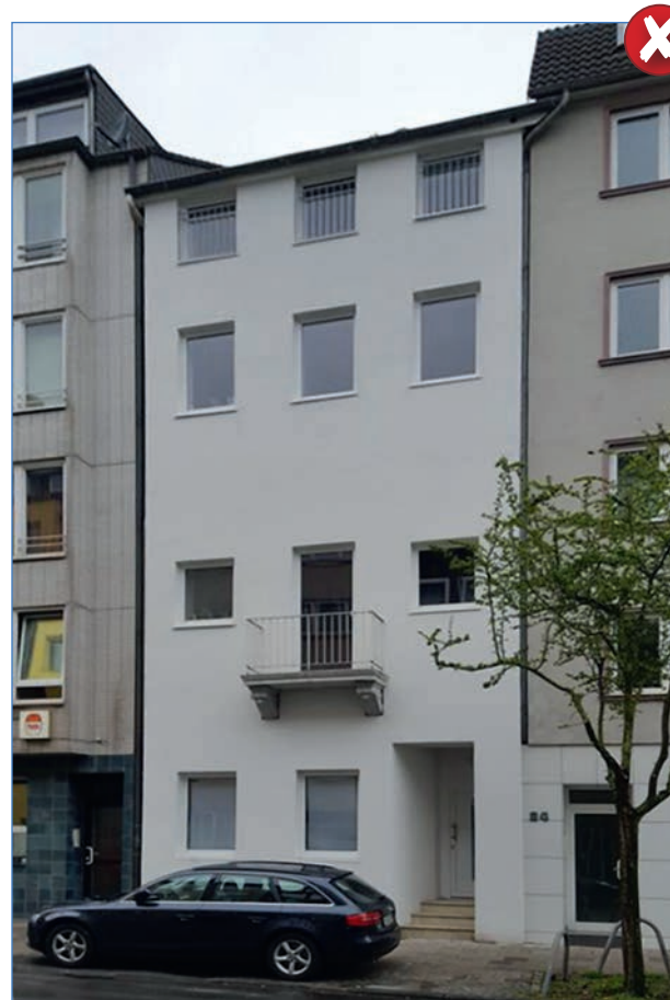
Abbildung 63: durch Wärmedämmung entstellte Fassade
