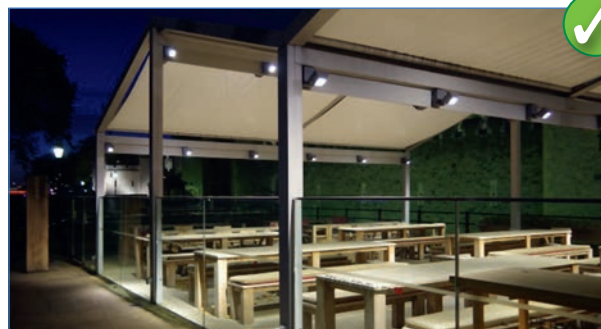
Abbildung 137: falls Windschutz erforderlich, auf dezente Gestaltung achten
