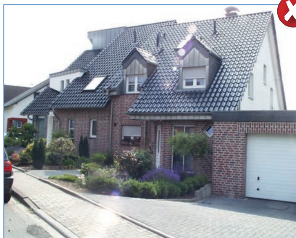
Abbildung 46: glasierte Dacheindeckung als Störfaktor im Straßensbild
