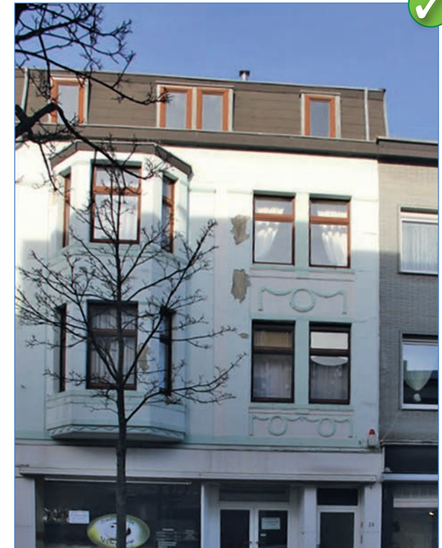
Abbildung 58: Erker am Gebäudealtbestand: untere Kleikstraße
