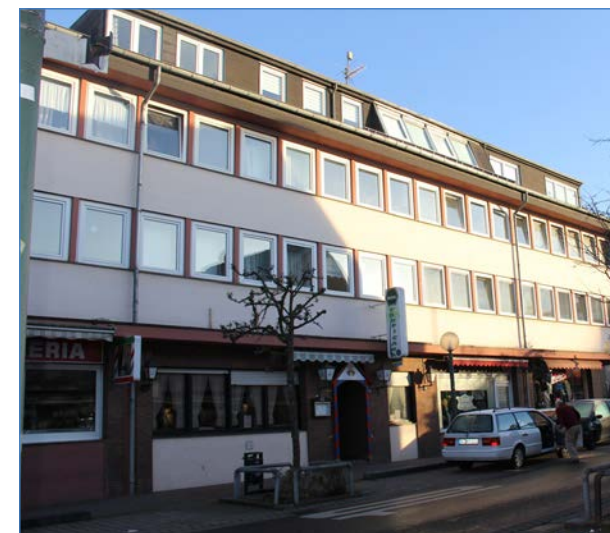
Abbildung 122: Wohn-/ Geschäftshaus in der Apolloniastraße mit horizontaler Fassadengliederung
