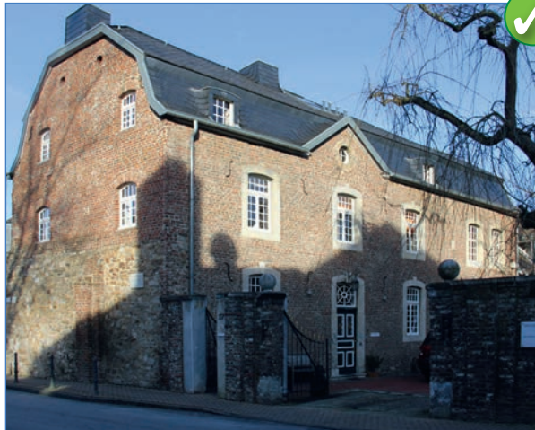
Abbildung 42: Mansarddach: Eyselshovener Straße
