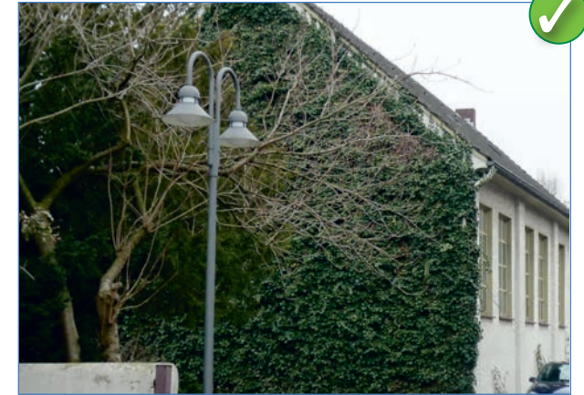
Abbildung 119: Fassadenbegrünung an einer Brandwand
