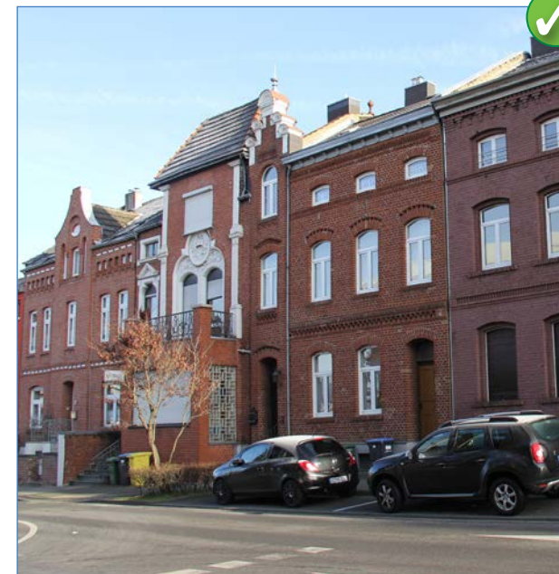
Abbildung 73: Backsteinensemble an der Bicherouxstraße: einheitliche Materialwahl bewirkt attraktives Gesamterscheinungsbild
