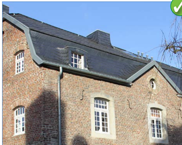
Abbildung 44: Schieferdeckung am Gebäudealtbestand; hier: Eygelshovener Straße
