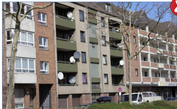
Abbildung 64: Die Häufung von Satellitenanlagen kann das Erscheinungsbild negativ beeinflussen
