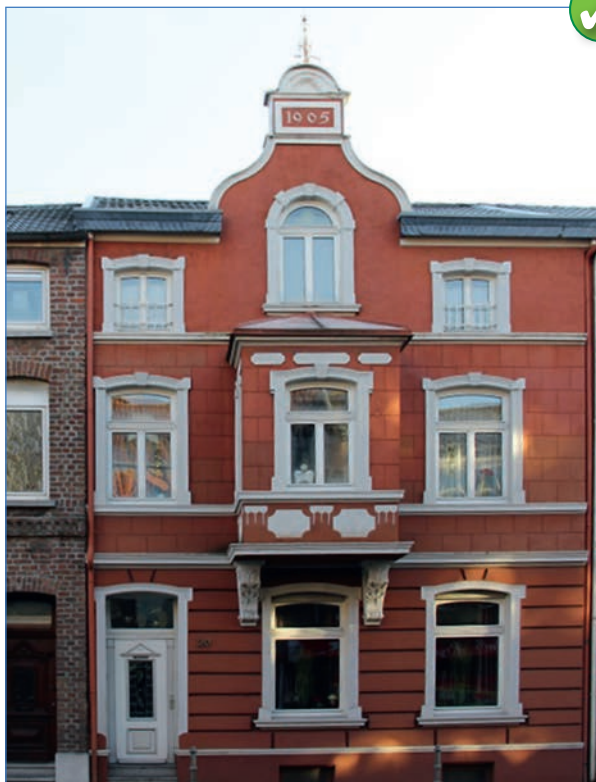
Abbildung 57: Erker am Gebäudealtbestand: Dammstraße
