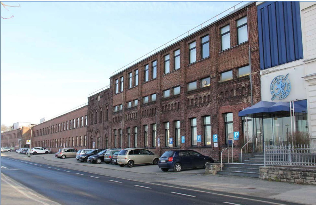
Abbildung 31: Firmengebäude Schmetz mit klarer Fassadengliederung
