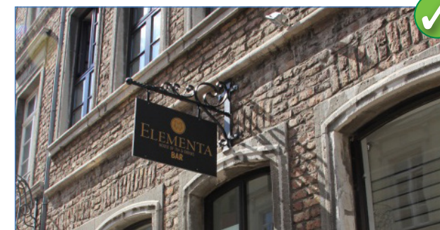
Abbildung 100: schlichte und einfache Werbeausleger fügen sich gut in die Fassadengestaltung ein
