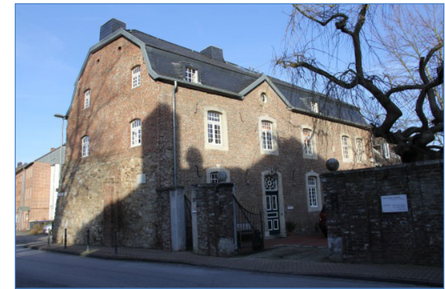
Abbildung 15: obere Kleikstraße: ehemaliges Pfarrhaus „St. Mariä Himmelfahrt“
