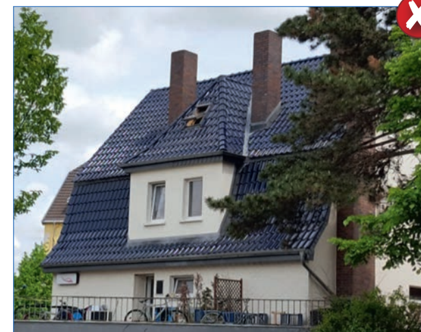
Abbildung 47: glasierte Dacheindeckung als Störfaktor im Straßensbild
