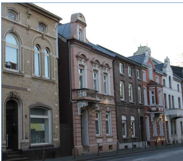
Abbildung 120: Straßenzug der „zwei Gesichter“ – deutlicher Kontrast der Bauepochen in der Dammstraße: Vorkriegs- und Nachkriegsbauten in direkter Nachbarschaft
