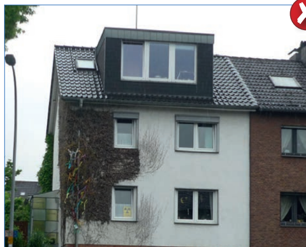
Abbildung 55: unmaßstäbliche Dachgaube ohne Fassadenbezug
