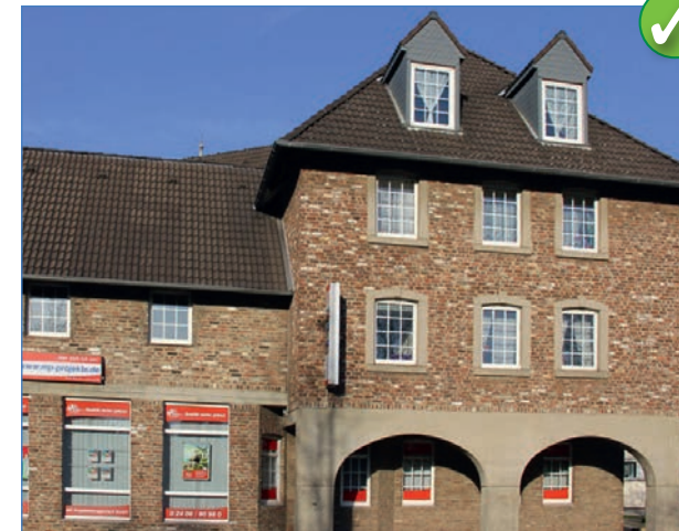
Abbildung 45: unglasierte Dacheindeckung; hier: Schütz-von-Rode-Straße
