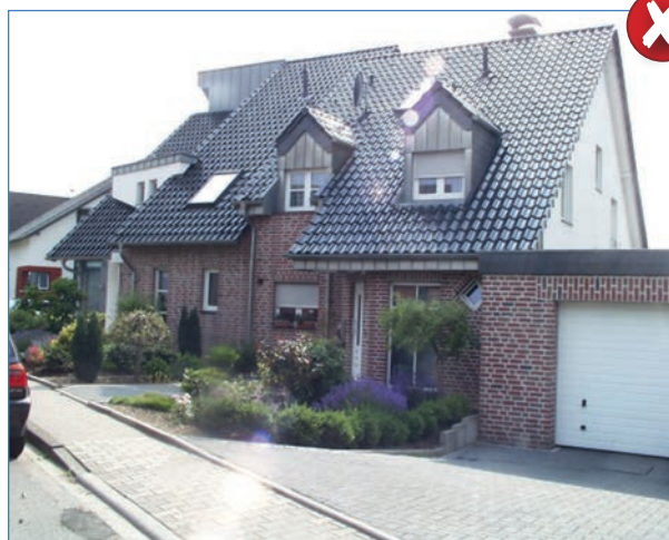
Abbildung 46: glasierte Dacheindeckung als Störfaktor im Straßensbild
