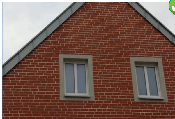
Abbildung 66: Ausführung der Fensterlaibung in Blausteinoptik bei einem Neubau
