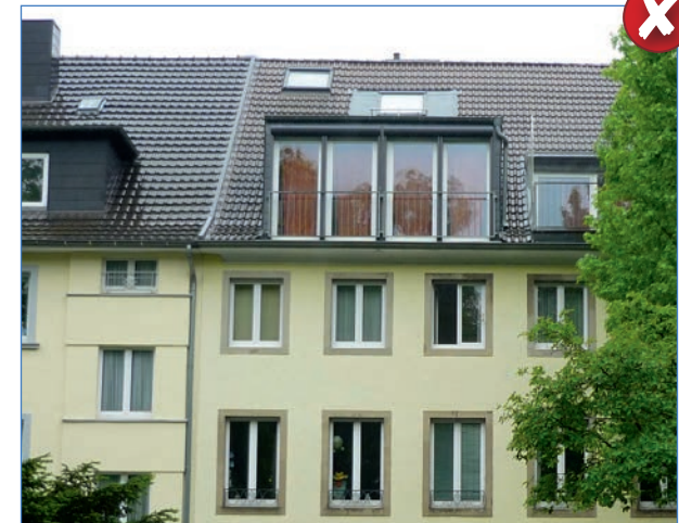
Abbildung 52: unmaßstäbliche Dachgaube ohne Fassadenbezug
