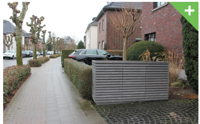
Abbildung 151: Mit hochwertigem Holzdesign versehene Mülltonneneinhausung im Vorgarten.
