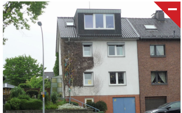
Abbildung 36: Wuchtige, zu groß gestaltete Dachgaube als Störelement.
