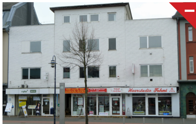
Abbildung 48: Orientierungslose Fassade und abgetrenntes, zusammenhangloses Erdgeschoss.
