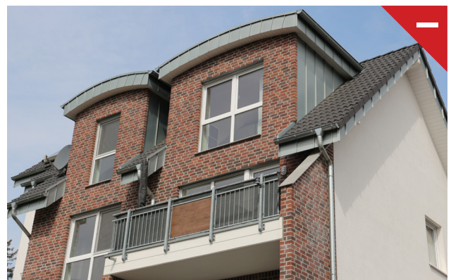
Abbildung 37: Zu einer Geschossaufstockung ausgeartete, das Dach vereinnahmende Zwerchgiebel.
