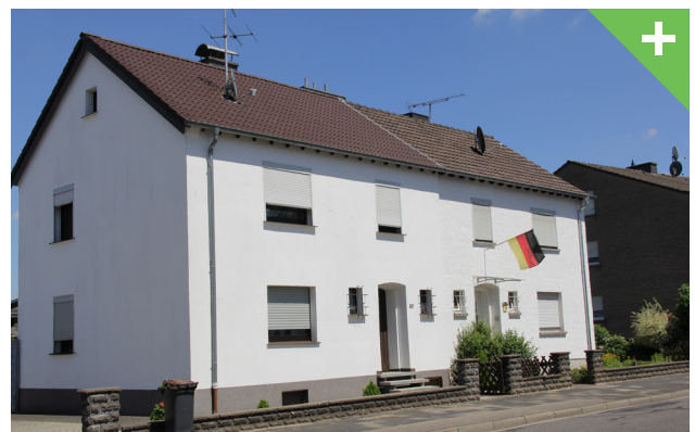
Abbildung 147: Aufgeräumte und durch niedrige Mauern dezent abgetrennte Vorgebäudezone.
