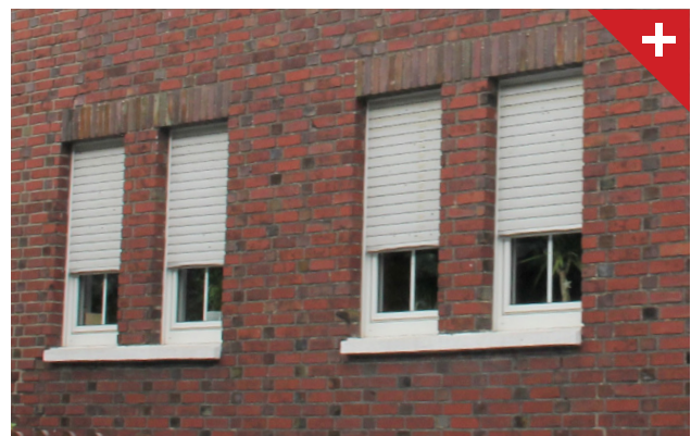
Abbildung 77: Im Fenstersturz unauffällig verbaute Rollläden, farblich an Fenster abgestimmt.
