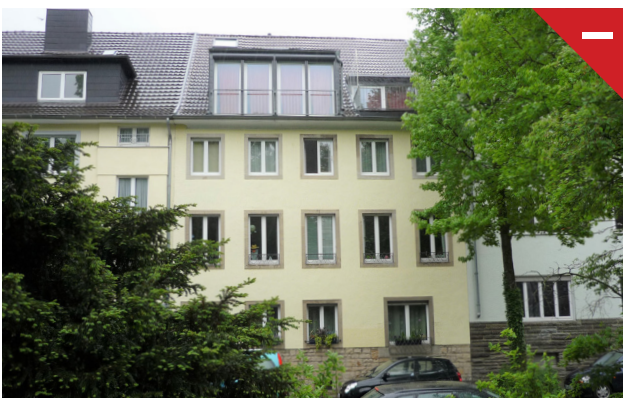
Abbildung 33: Aufgesetzte und überdimensionierte Langgaube als Störfaktor.
