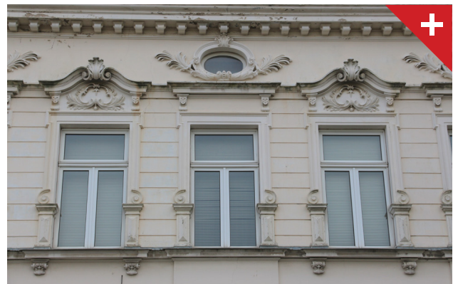
Abbildung 69: Ausgeschmückte und in Fassade integrierte Fensterformate und Sprossungen.
