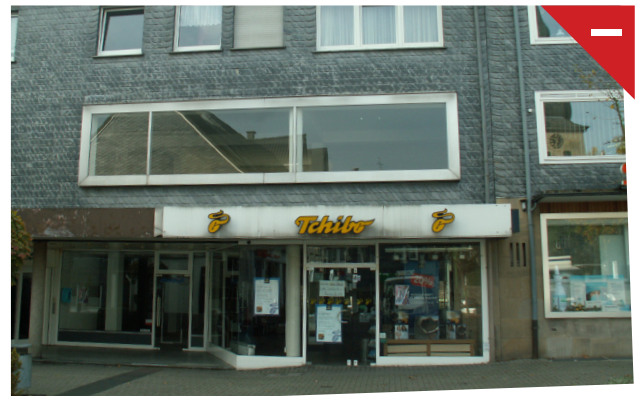
Abbildung 74: Zerstörung der Gebäudearchitektur durch Fülle an Schaufenstern bis ins Obergeschoss.
