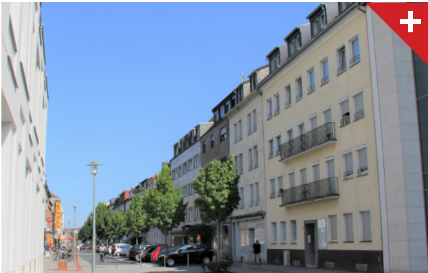
Abbildung 31: Die Fensterachsen der Fassade fortführende Einzeldachgauben.
