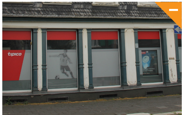
Abbildung 141: Schaufenster sollen als solche genutzt und nicht abgehängt oder zugeklebt werden.
