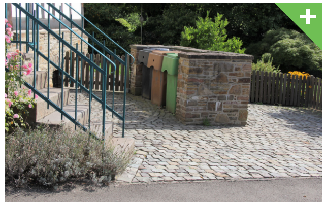
Abbildung 150: Zur Gebäudegestaltung passende Mülltonneneinhausung.
