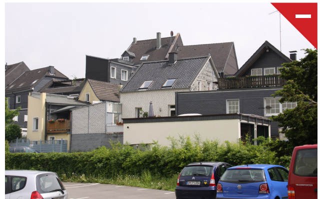
Abbildung 20: Unruhiges Bild durch unterschiedliche Dachformen auf engem Raum.
