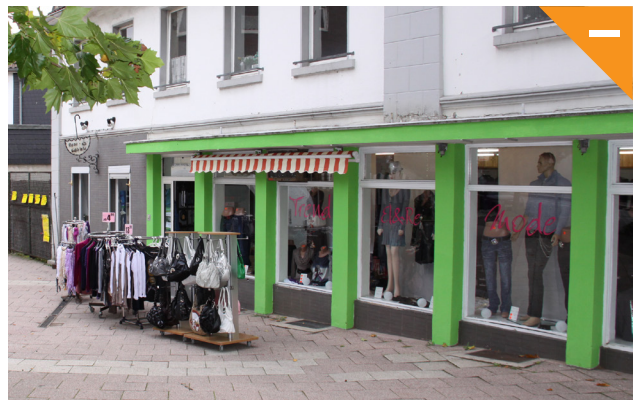
Abbildung 140: Die farbliche Einfassung von Schaufensterrahmen ist nicht erlaubt.
