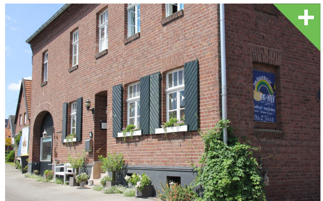
Abbildung 146: Liebevoll gestaltete und begrünte Vorgebäudezone.
