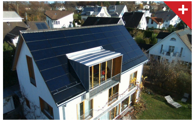
Abbildung 38: In Dachhaut integrierte Solaranlagen in dunklen, zurückhaltenden Farben.
