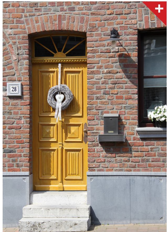
Abbildung 67: In Material und Farbe an die Fassade angepasste Holztür.
