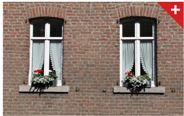
Abbildung 68: Attraktives Fensterformat mit weißem Rahmen und Fenstersprossen.
