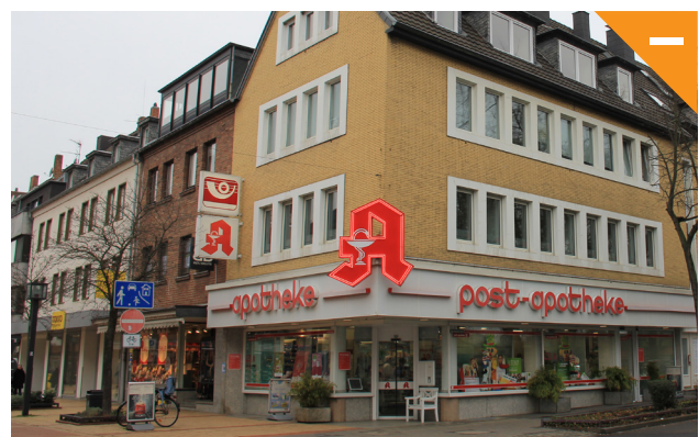
Abbildung 115: Auffällige, überdimensionierte Werbeobjekte bis in die Obergeschosse sind nicht erlaubt.
