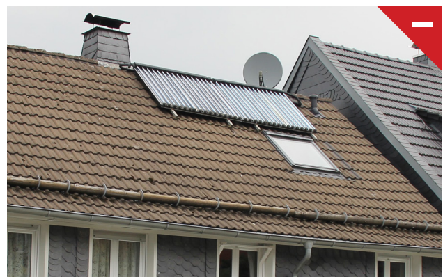
Abbildung 41: Einzelne, andersfarbige und spiegelnde Solaranlage fällt auf der Dachfläche auf.
