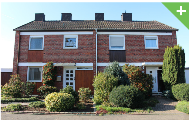
Abbildung 145: Grüne und lebendige Vorgärten in der Vorgebäudezone.
