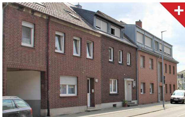
Abbildung 54: Abgestimmtes Fassadenmaterial und Farbspektrum in einem Straßenzug.
