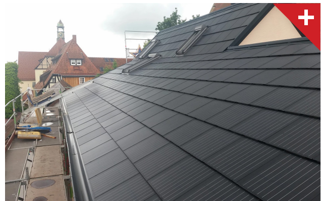
Abbildung 39: Solarziegel, die sich von herkömmlichen Dachziegeln fast nicht unterscheiden.
