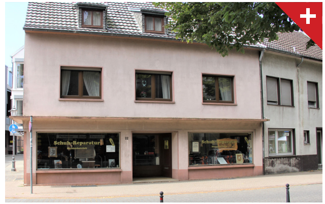
Abbildung 34: Dem Dach- und Fassadenbild untergeordnete, harmonisch einfügende Gauben.
