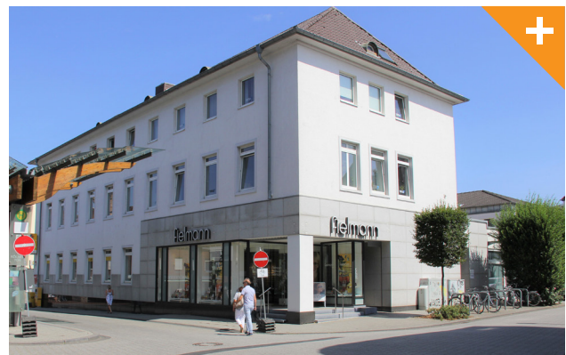
Abbildung 113: Zurückhaltende Werbung im Erdgeschoss erhält das Erscheinungsbild des Gebäudes.
