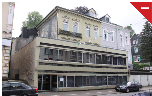
Abbildung 12: Störung des Erscheinungsbildes durch unpassenden, überdimensionierten Anbau.
