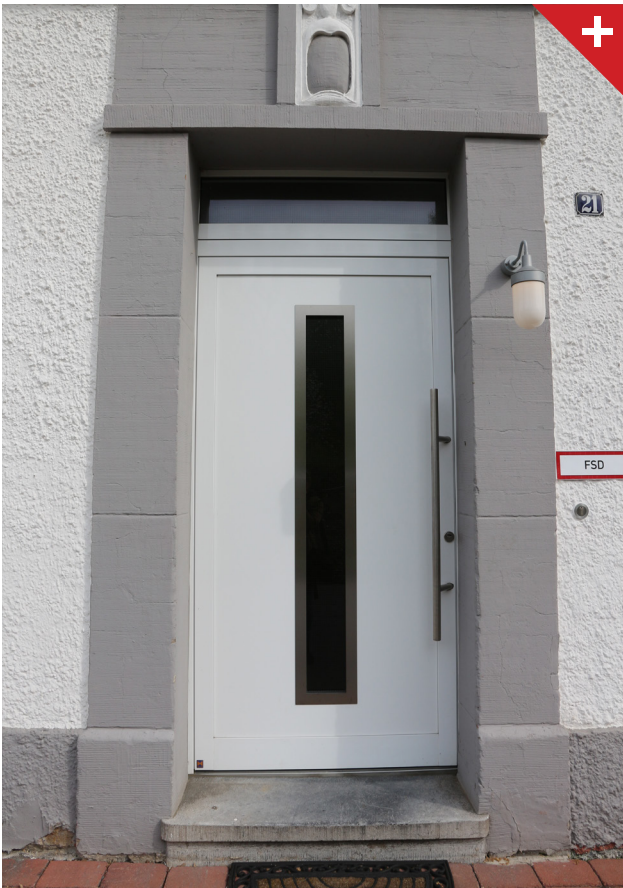
Abbildung 64: Moderne, hochwertige Tür in Symbiose mit historischer Bausubstanz.
