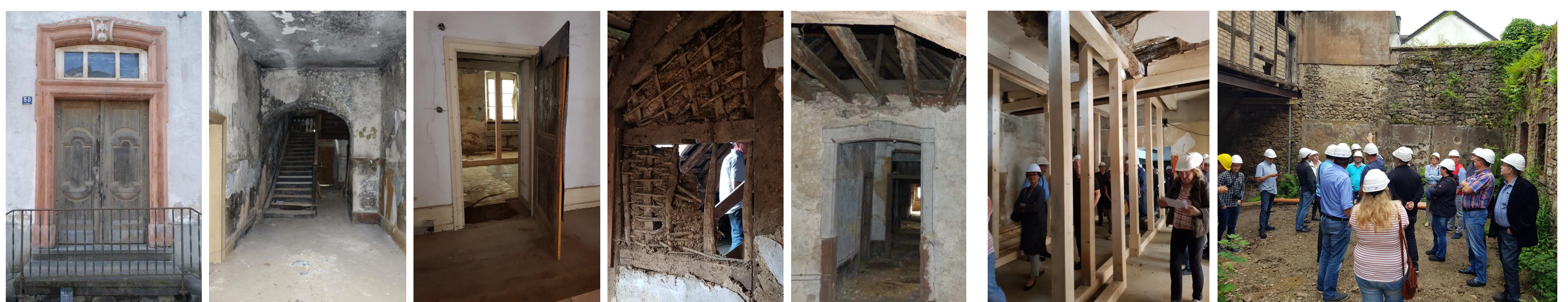
Zusammenschau des Sanierungsbedarfes
