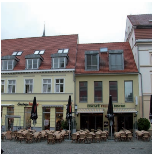
Neues Bauen in alten Strukturen, Greifswald
