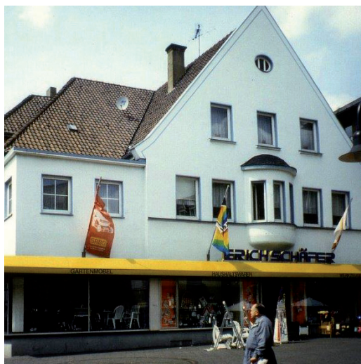
Fassadengliederung, Ibbenbüren - VORHER
