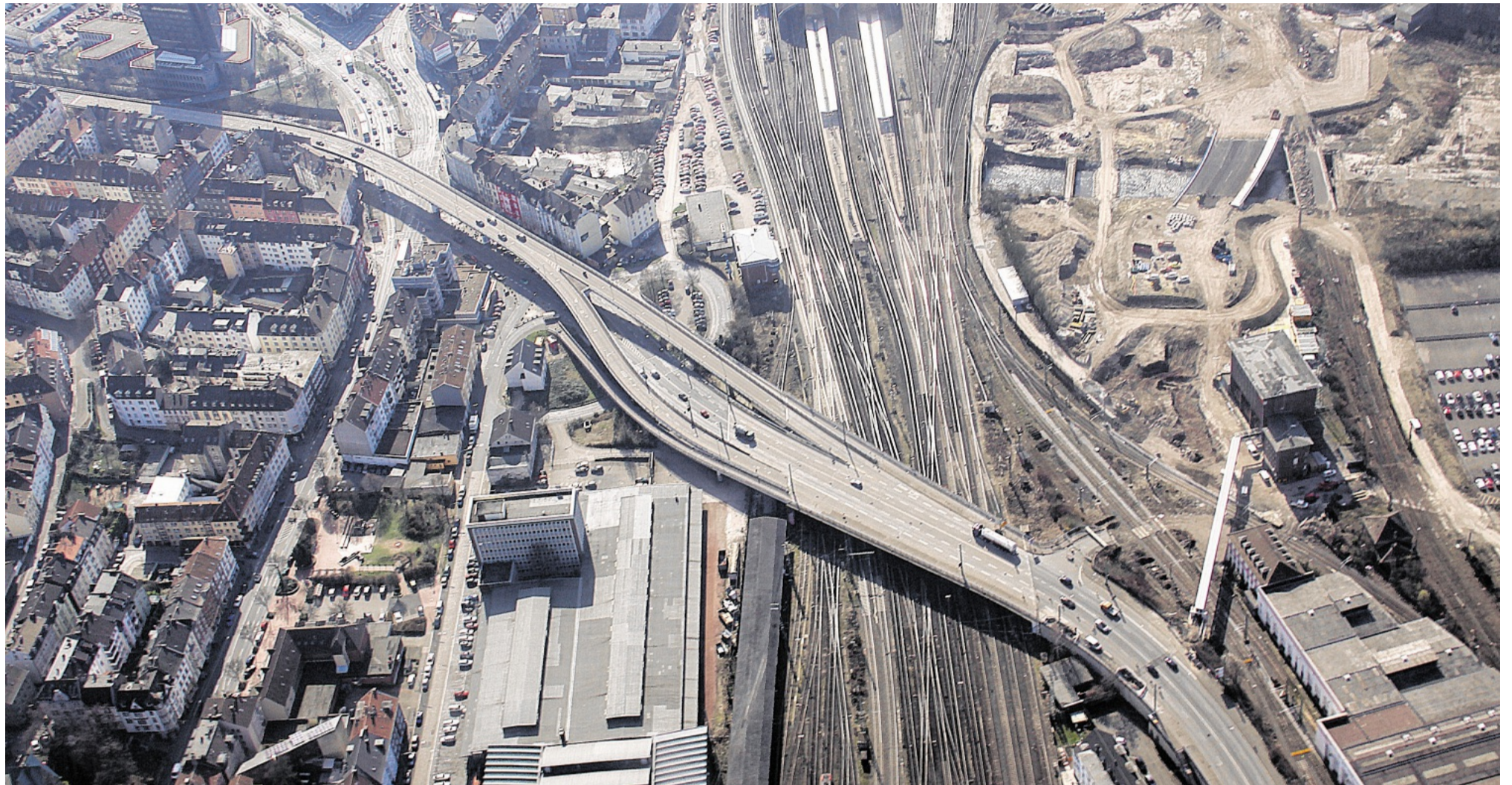
Die B 54 überspannt nicht nur die Altenhagener und Fehrbelliner Straße, sondern auch die gesamten Gleisanlagen am Bahnhof. Entsprechend kompliziert gestaltet sich ein möglicher Abriss. FOTO: WOLFGANG MESENHOLL
